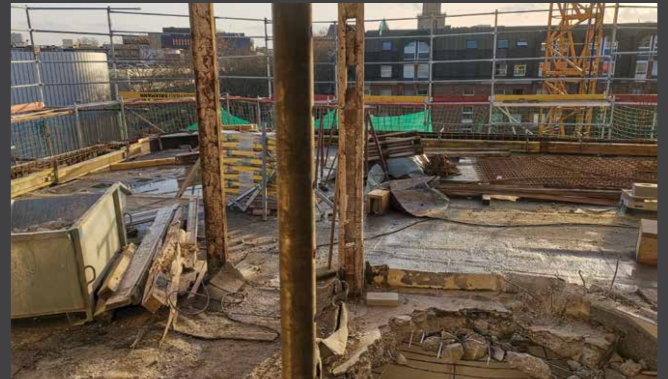
2018 fällt der Startschuss zur Hotel-Erweiterung.
