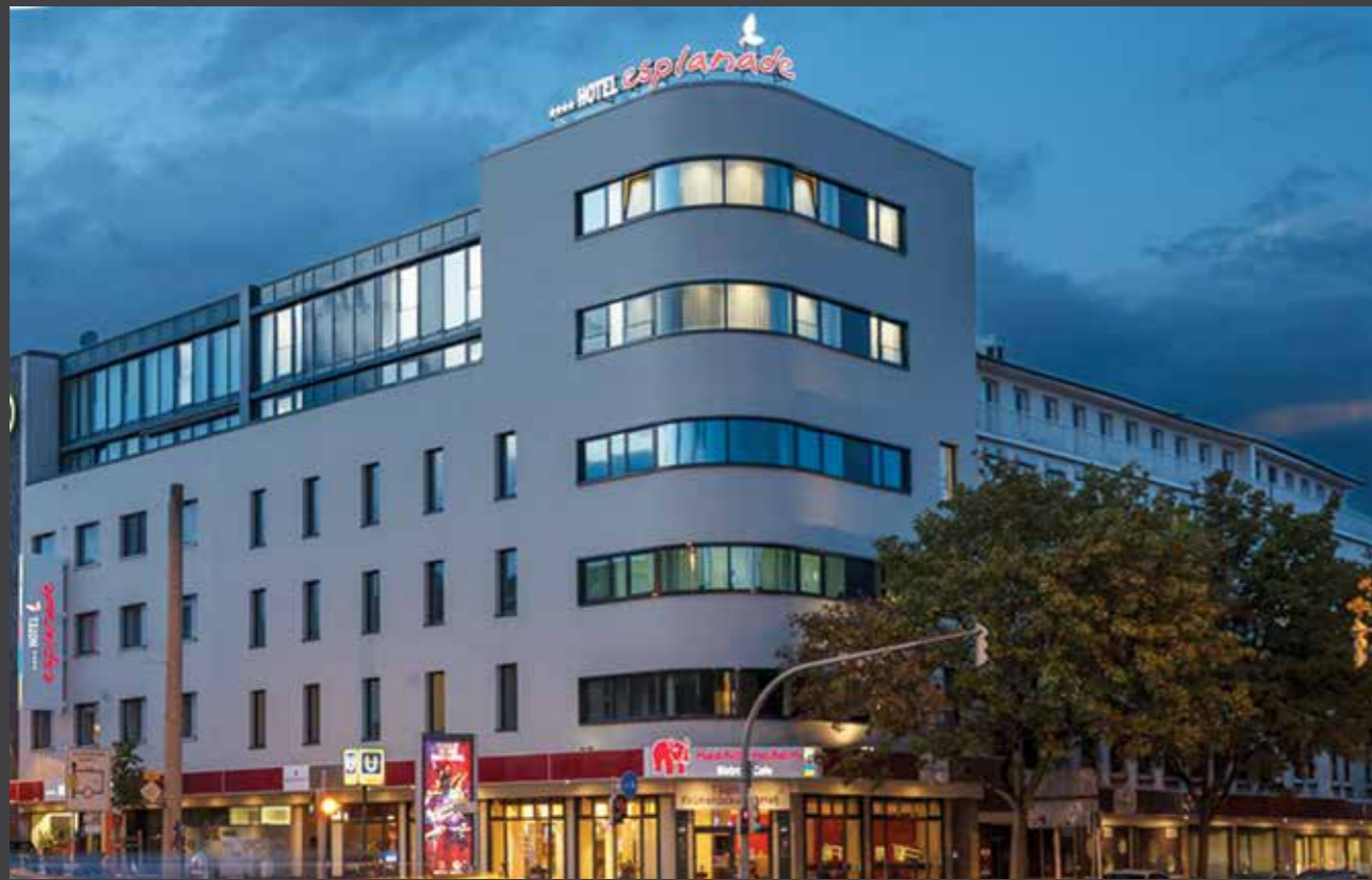
Die neue Fassade des Hotels Esplanade.
